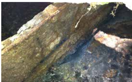
Skadad mellanvägg, risk för slamflykt.
